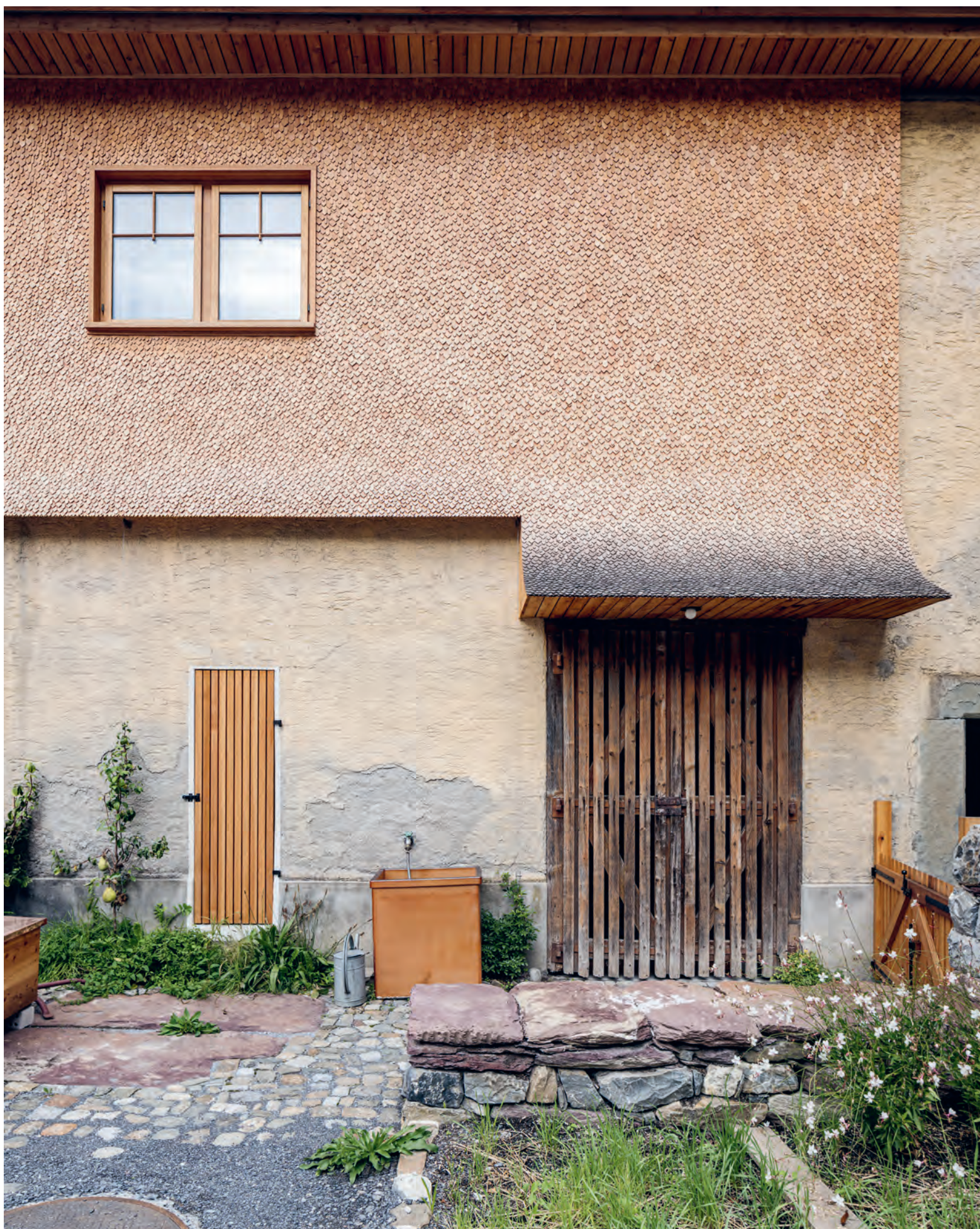
Mit neuem Dach und gedämmter Schindelhaut steht die Mühle Ennenda im Dorfverband. Die Gartenmauern sind ebenso wie das Sockelgeschoss aus Verrucano gemauert. →
